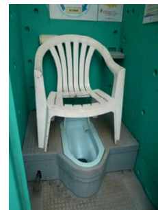
写真2 和式トイレに設置されたイス
